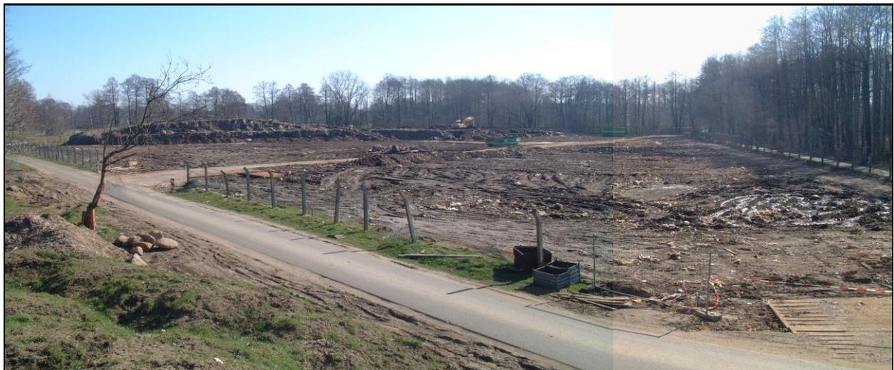
Insgesamt wurden 132.610 Mg Abfall aufgenommen, teilweise sortiert, verwertet und auf den Deponien Spremberg, Welzow, Guben und Reuthen abgelagert. Der Deponieuntergrund, ein humusreicher Torfboden, konnte nahezu vollständig von Abfall befreit werden.
