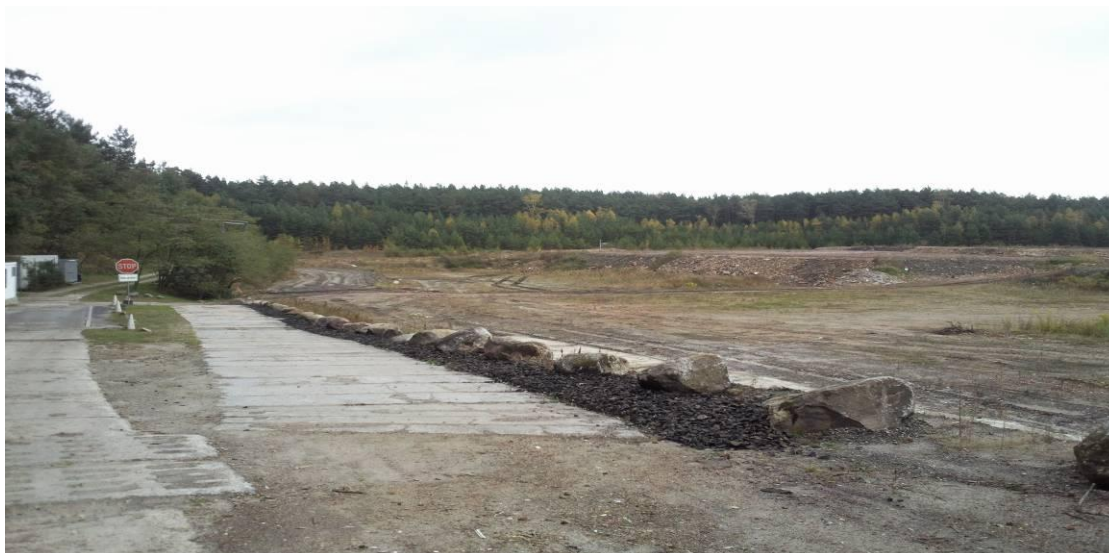
Ansicht der Deponie 2011
