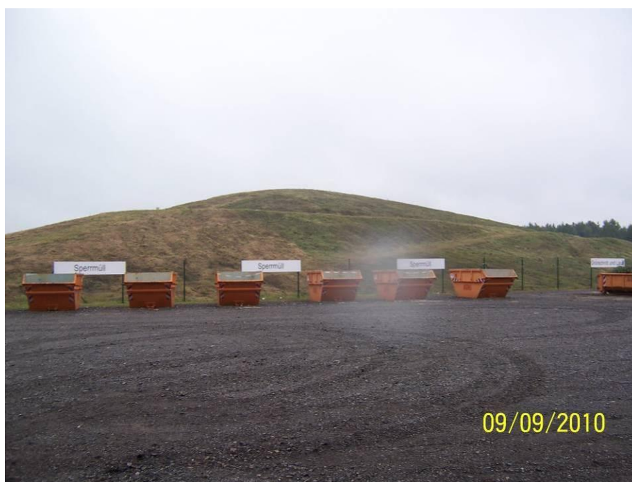
Ansicht des Deponiekörpers (Aufnahme 2007 vom zwischengelagerten Abdeckboden her)
