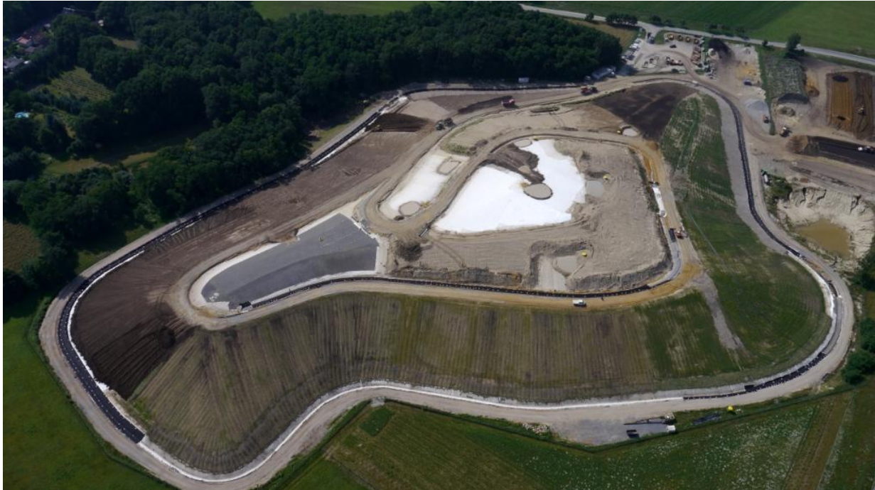
Bau der Oberflächenabdichtung 2012
