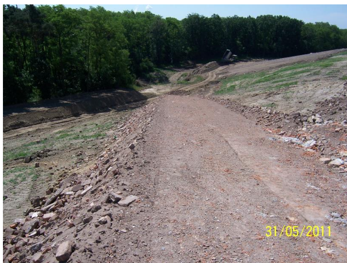
Abbildung 3: Bau Auffahrt mit Gemischen aus Beton, Ziegel, Fliesen und Keramik auf der Deponie Spremberg-Cantdorf
