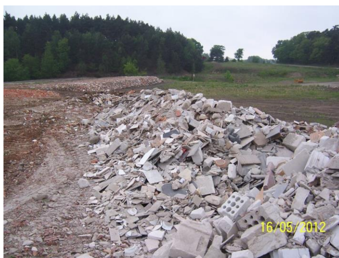
Abbildung 2: Zur Profilierung eingesetzte Gemische aus Beton, Ziegel, Fliesen und Keramik
