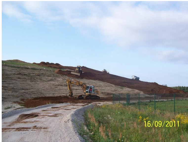
Abbildung 4: Herstellung der Trag- und Ausgleichsschicht mit Baggergut
